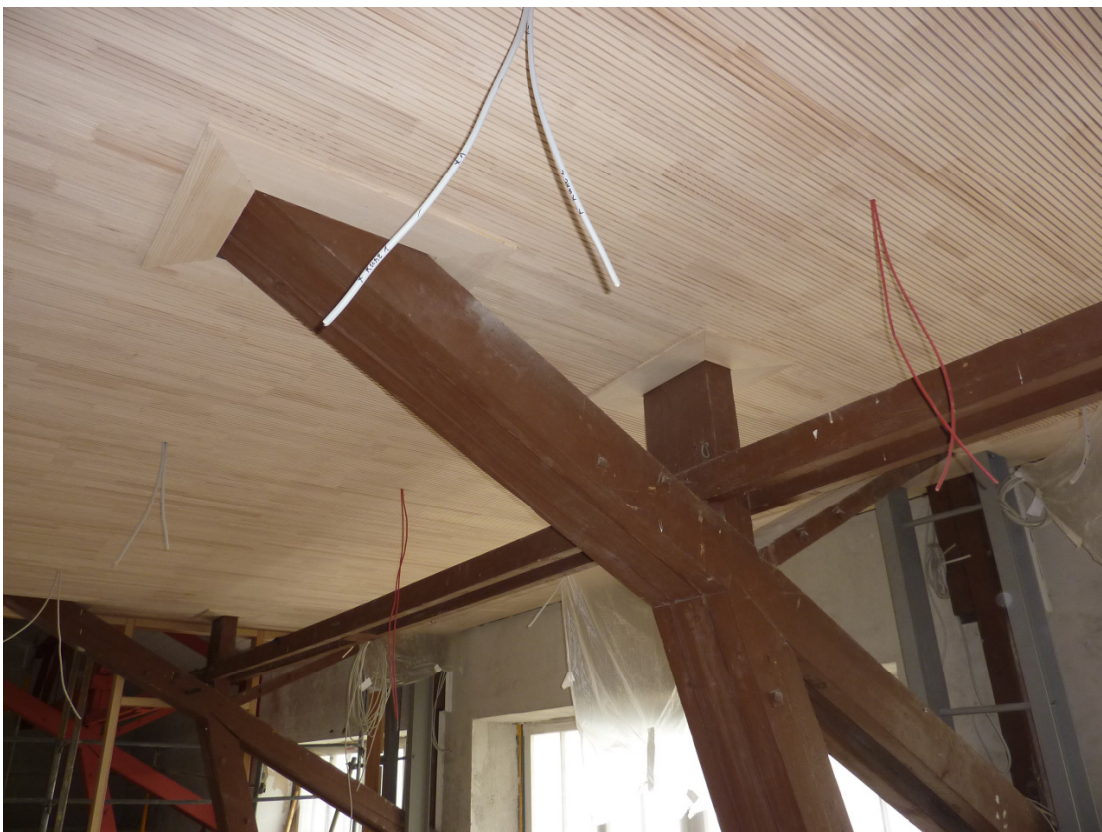
Durchdringung Bestandstragwerk und Holzdeckenelement nach Verkleidung
