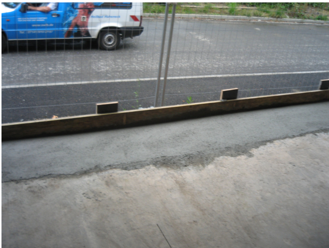
Anarbeitung des Sockelabbruchs
