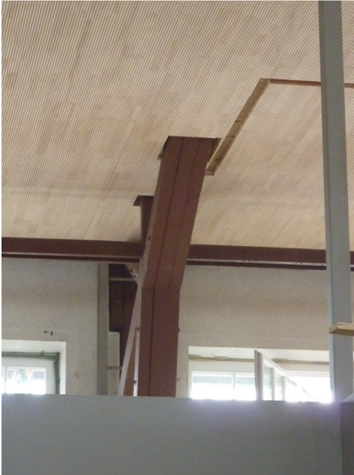
Durchdringung Bestandstragwerk und Holzdeckenelement vor Verkleidung
