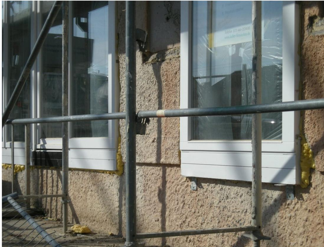
lotrechter Einbau der Fenster bedingt zusätzlichen Putzauftrag
