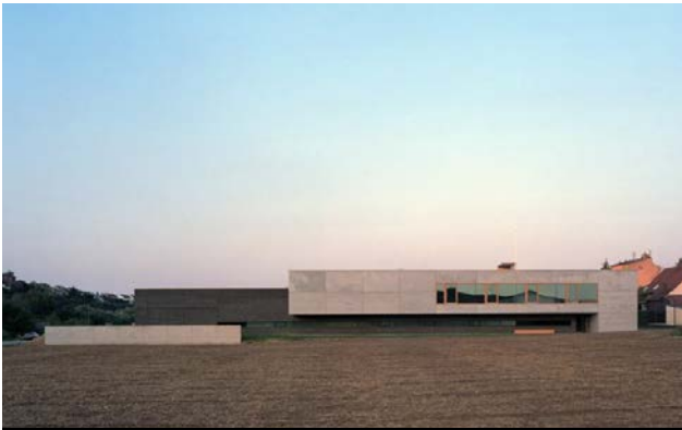
2003 neubau feuerwehrgerätehaus lauffen am neckar bauherr stadt lauffen am neckar
