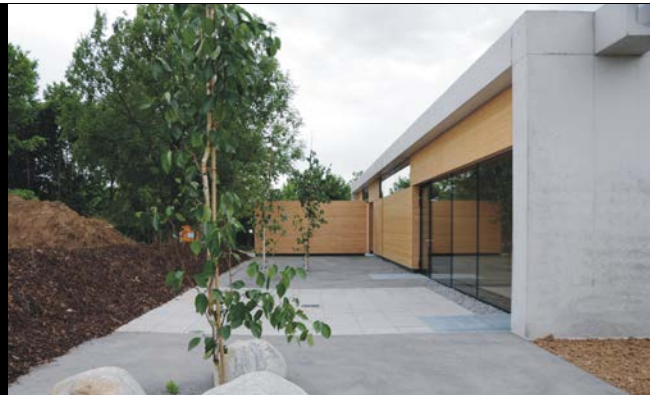
2006 neubau förder- und betreuungsgruppe längelter talheim bauherr beschützende werkstätte heilbronn
