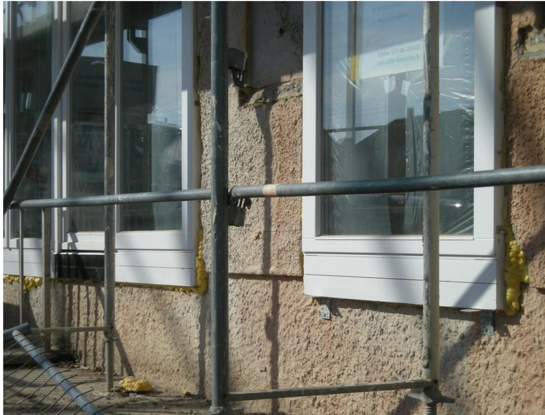
lotrechter Einbau der Fenster bedingt zusätzlichen Putzauftrag
