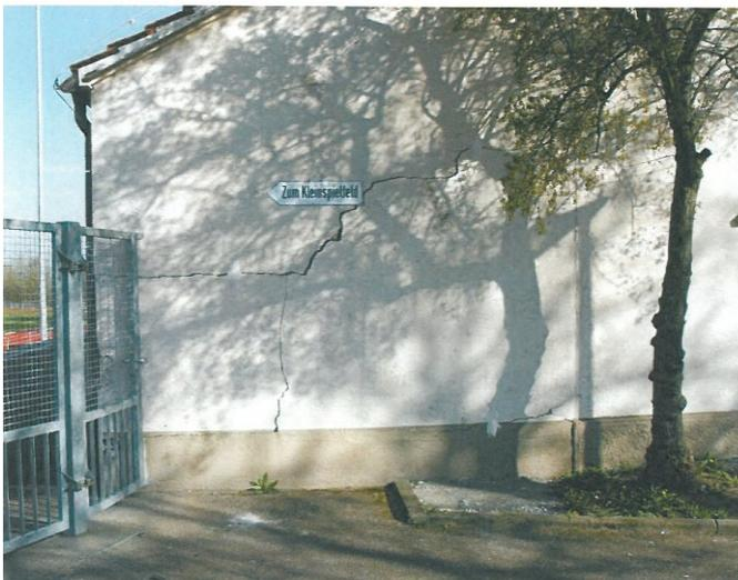
Bild 2: Rissbild des großen Risses auf halber Geschosshöhe im Anbau und Horizontalriss nahe des Baums ca. 50 cm über dem Gelände
