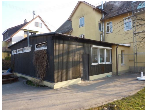
Anbau mit Umkleide / Waschraum / WC
