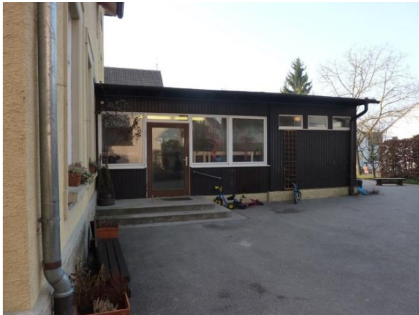
Eingang Anbau Bestand
