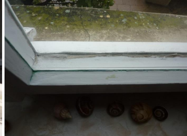
Zustand Fenster Anbau
