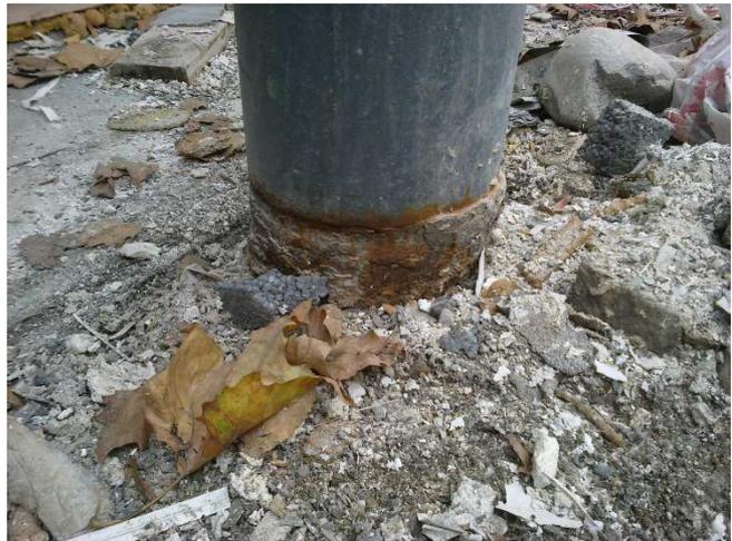
Schlosserarbeiten: Korrosion Stahlstützen Hauptbau
