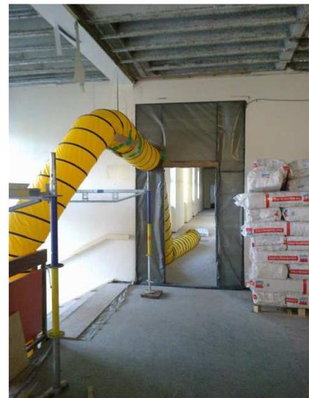
Rohbauarbeiten: Folienwände als Schutzmaßnahme und zur Baubeheizung
