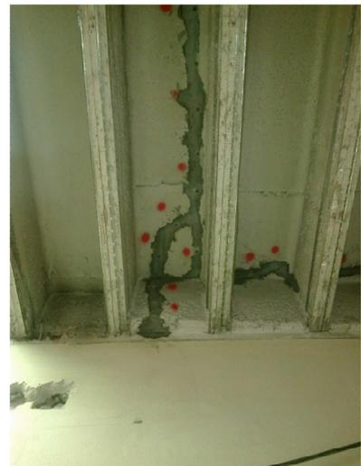
Rohbauarbeiten: Betonsanierung Rippendecken, Risse verpressen
