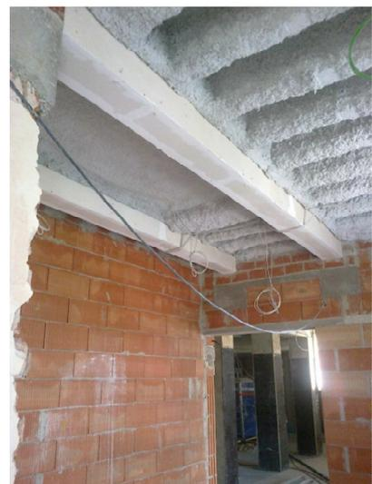
Rohbauarbeiten: Einbau zusätzl. Stahlträger, Verkleidung mit Brandschutzplatten
