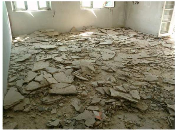
Rohbauarbeiten: Abbruch Steinholzestriche
