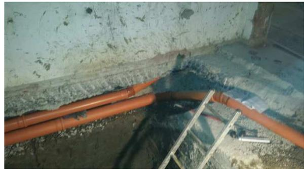
Rohbauarbeiten: Suchen und Freilegen Grundleitungen, Grundleitungen erneuern
