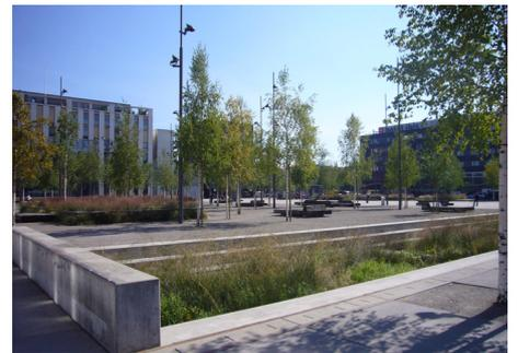
Abbildung 57 - Ein Regen-Rückhaltebecken dient gleichzeitig der ökologischen und ästhetischen Aufwertung und als Aufenthaltsraum für Bedienstete und Besucher (Turbinenplatz, Zürich)
