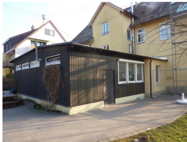
Anbau mit Umkleide / Waschraum / WC
