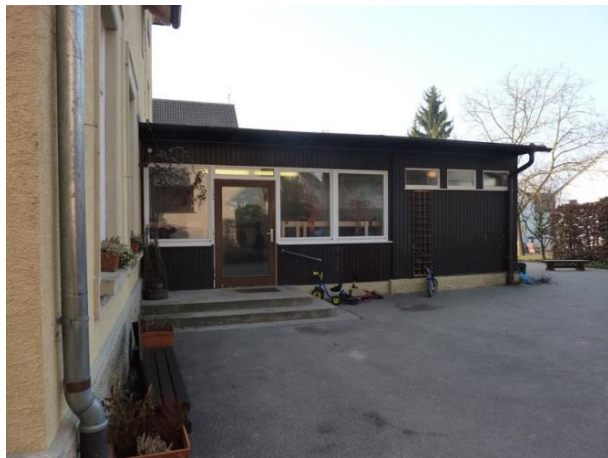
Eingang Anbau Bestand
