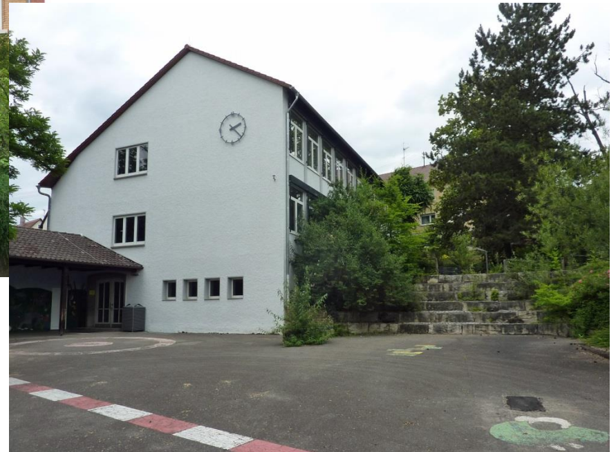
Rückwärtiger Erweiterungsbau (Abbruch)
