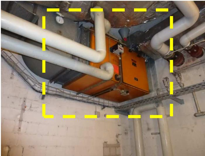
Lüftung ohne Wärmerückgewinnung
