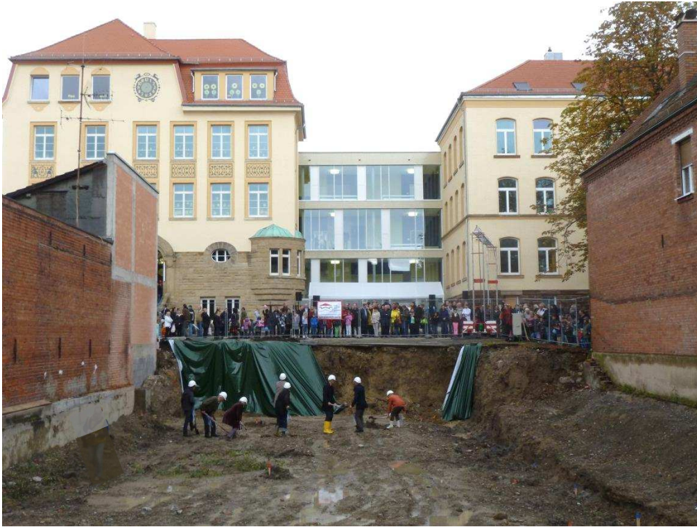
Neubau Mensa mit Bewegungsraum: Spatenstich 10.10.2013
