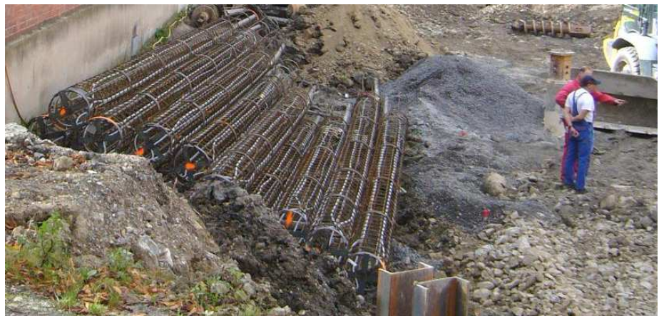
Einbringen der thermisch aktiven Bohrfähle (Kühlung) in den Erdboden
