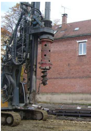
Einbringen der thermisch aktiven Bohrfähle (Kühlung) in den Erdboden
