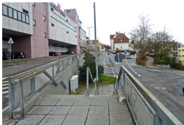
Abbildung 3: Stützmauer mit Treppenanlage
