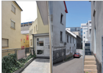
Schillerstraße: Rückwärtige Bereiche und Nebengebäude
