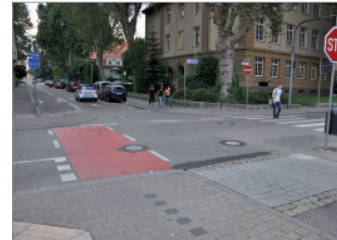
Alleen-/Solitudestraße: Gefahrenpunkt durch Überlagerung von Verkehrsarten
