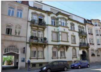
Mathildenstraße: Historische, denkmalgeschützte Gebäudesubstanz
