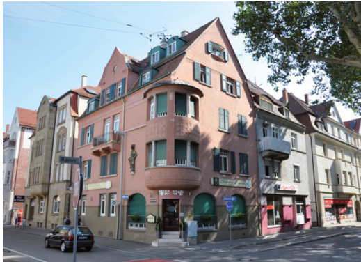
Abb. 35: Solitude-/Alleenstraße: Gebäude mit Wohnnutzung in den Obergeschossen
