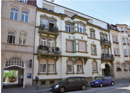
Abb. 38: Mathildenstraße: Historische, denkmalgeschützte Gebäudesubstanz
