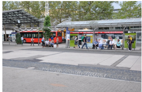
Abb. 26: Umfeld des ZOB mit Gestaltungsmängeln
