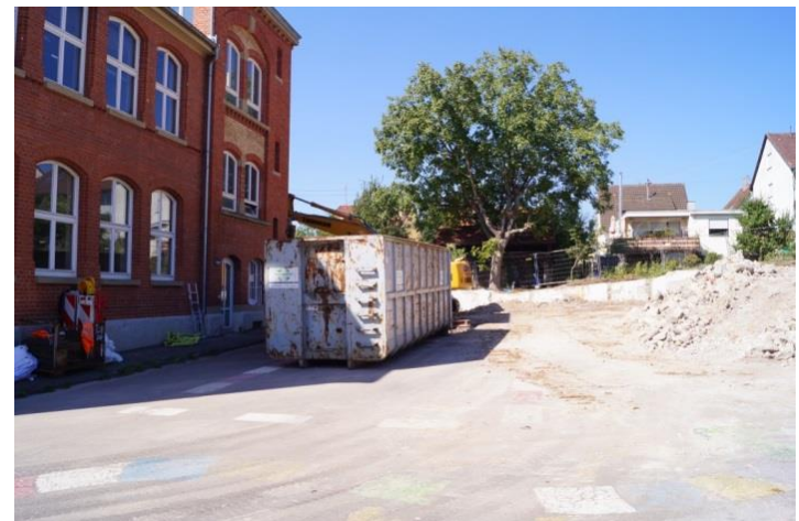
Rückwärtiger Erweiterungsbau (Abbruch)
