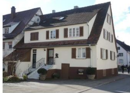
Ansicht des Wohnhauses von Nordosten
