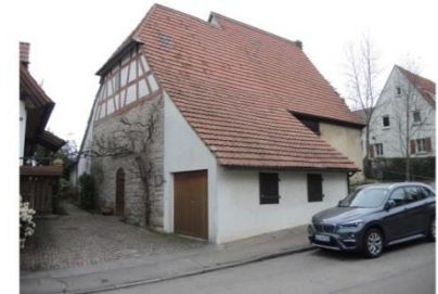
Ansicht der Scheune von Südwesten
