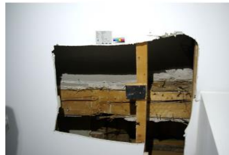
Foto 11: Sondage 6 in der untergehängten GK-Decke.
