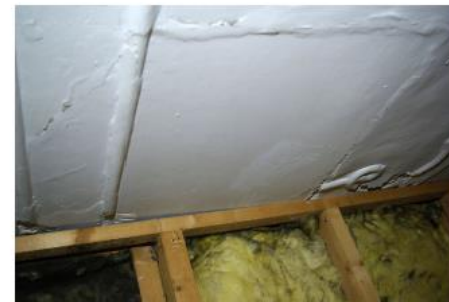
Foto 12: Blick auf die bauzeitliche Stuckdecke sowie die moderne Rahmenkonstruktion einer Trennwand.
