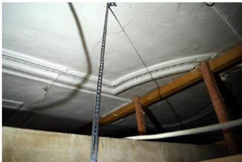
Foto 21: Blick auf die Stuckdecke von 1722.
