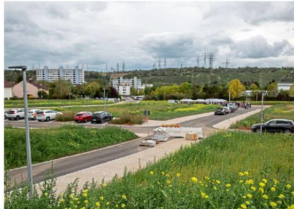
Am Rand von Neckarweihingen entsteht ein neues Wohngebiet.
