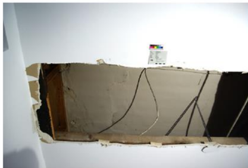
Foto 20: Sondage in der GK-Decke; Sondage 10.
