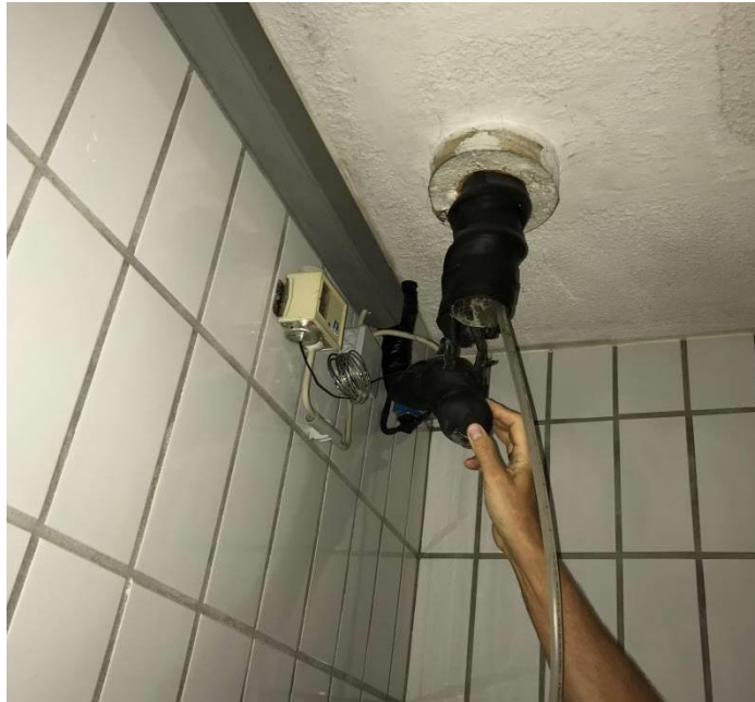
Mangelhafter Deckendurchbruch in Kühlräumen.
