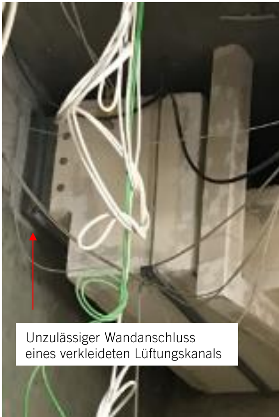
Brandschutztechnische Verkleidung von Lüftungskanälen
