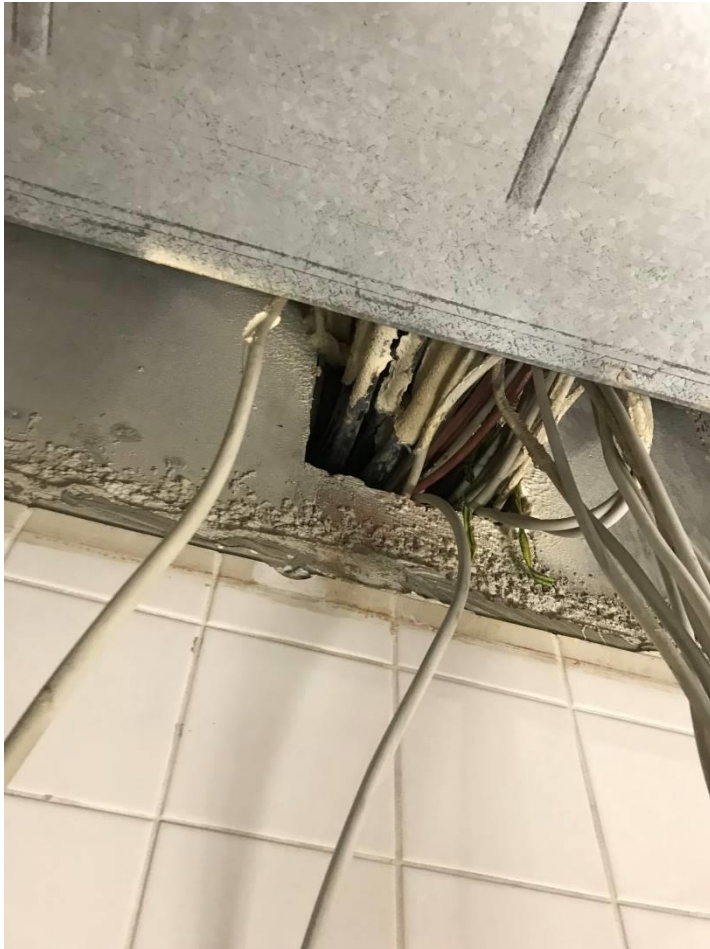
Fehlende Schottung zwischen Brandschutzabschnitten
