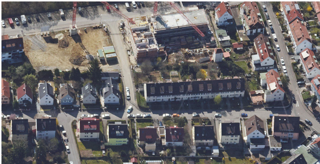
Abbildung 1: Schrägluftbild 2019, Blick Richtung Süden (Quelle: Stadt Ludwigsburg)
