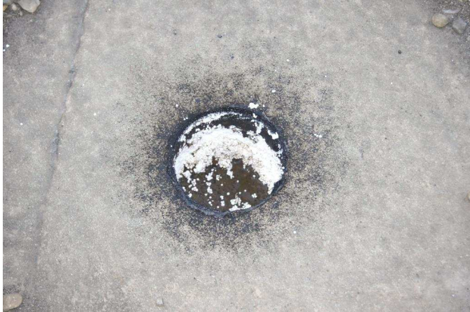
Bild 8: Feuchtigkeitsmessung unterhalb der Polystyrolämmung
