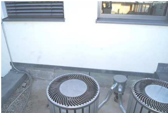
Bild 4: Flachdachbereich gegenüber Sportgeräteraum
