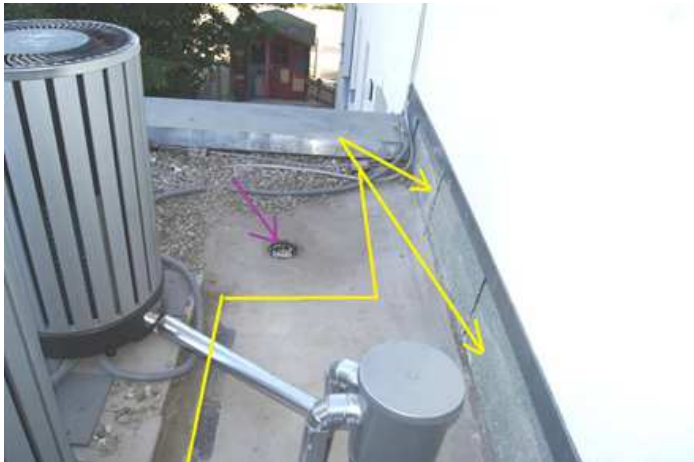
Bild 5: Ansicht Wandanschluss und Lage der Probeöffnung
