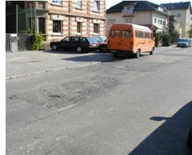
Oberflächenschäden
