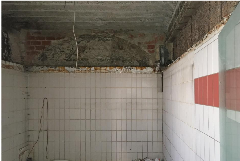
Erdgeschoss Dampfbad → WC-Bereich, Rippendecke
