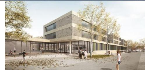
**Kennwert BZW Neubau, Holz-Hybrid-Konstruktion: ca. 2.552 € brutto /m<sup>2</sup> BGF (KG 300 + 400)**
