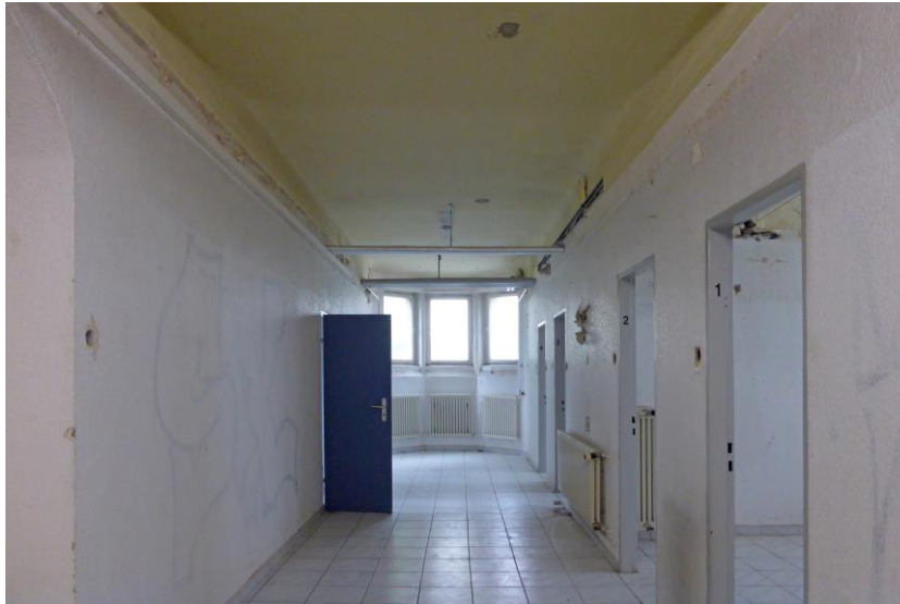
Untergeschoss ehemalige Wannenbäder → Flur 2, Teeküche
