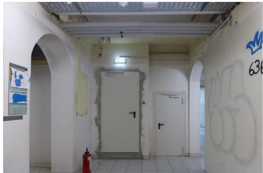
Untergeschoss Nebeneingang → Eingangsbereich
