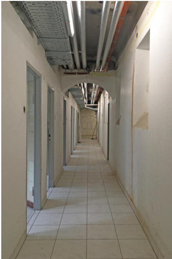
Untergeschoss ehemalige Massagepraxis → Flur 1,
