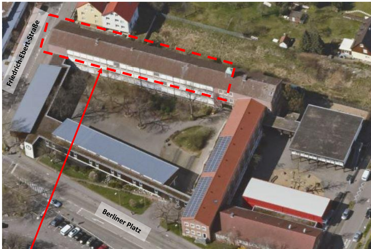
Umbau 2. Obergeschoss, Altbau, in neuen erweiterten Fachklassentrakt
