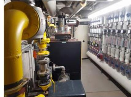
Abbildung: Alte Gaskesselanlage Schulkomplex Eglosheim. Durch die geplante Fernwärmeanbindung können jährlich über 200 Tonnen CO<sub>2</sub> eingespart werden.
