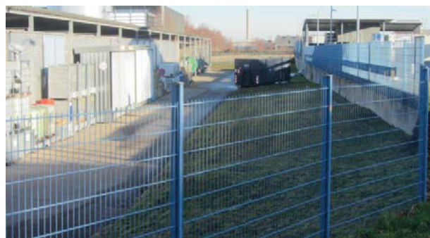
Abb. 46: Lagerhalle im Nordwesten, alter BPlan Schlieffenstraße West Waldäcker
