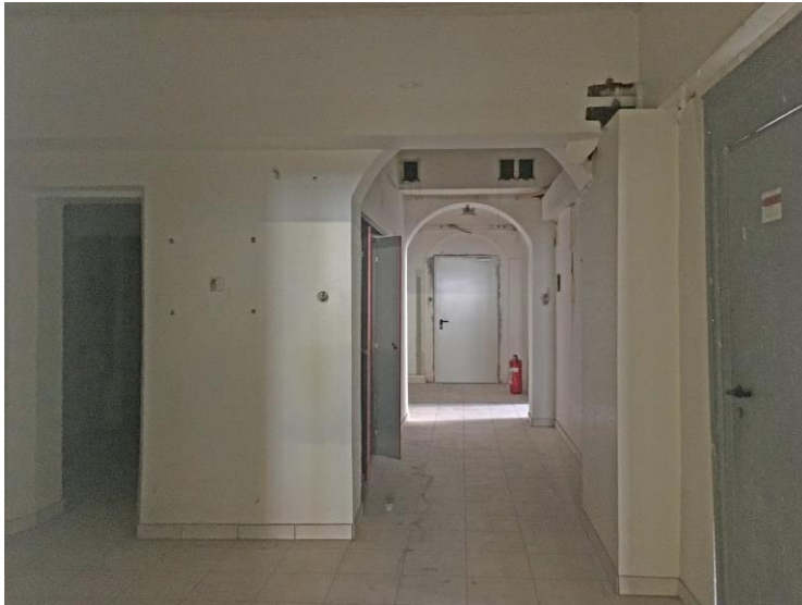
Untergeschoss Flur, Nebenräume
