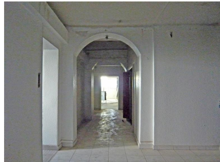
Untergeschoss Flur, Nebenräume
