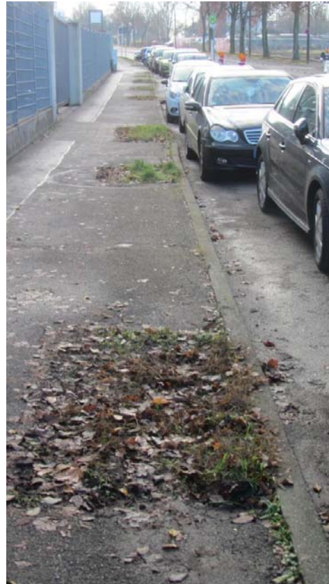
Abb. 37: Gehweg mit ehemaligen Baumquartieren östliche Grenze des Planbereichs
