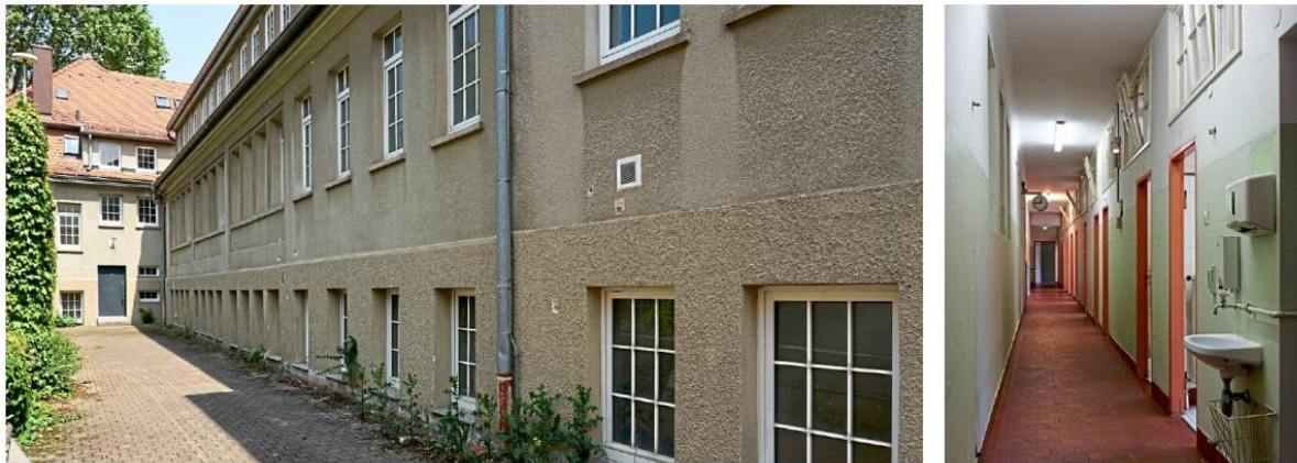
Das Stadtbad von der südlichen Seite (links): Hier wird der Zugang zu den Räumen der Filmakademie sein. Innen (rechts, Foto von 2017) ist noch im Rohbau und wird jetzt saniert. Fotos: Andreas Becker
