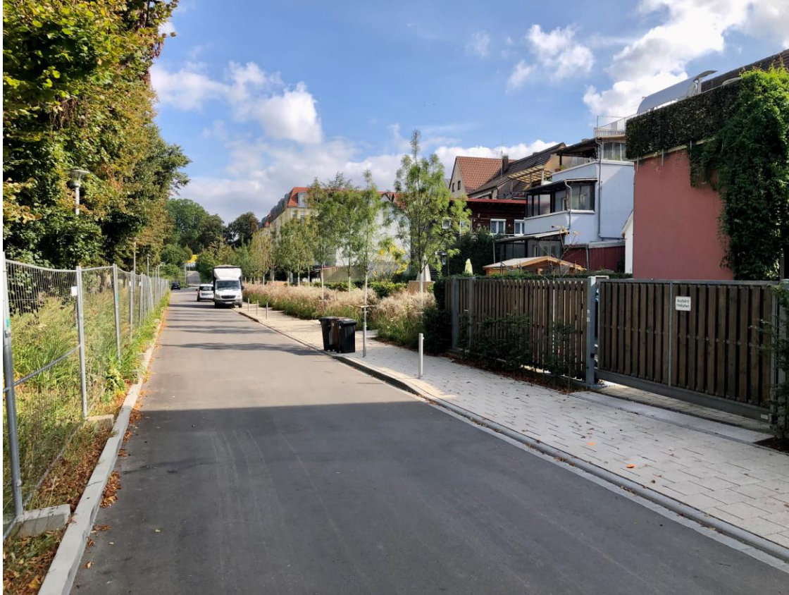
Sanierung Untere Kasernenstraße
