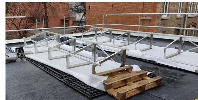
Flachdach Innenhof Obere Marktstraße
