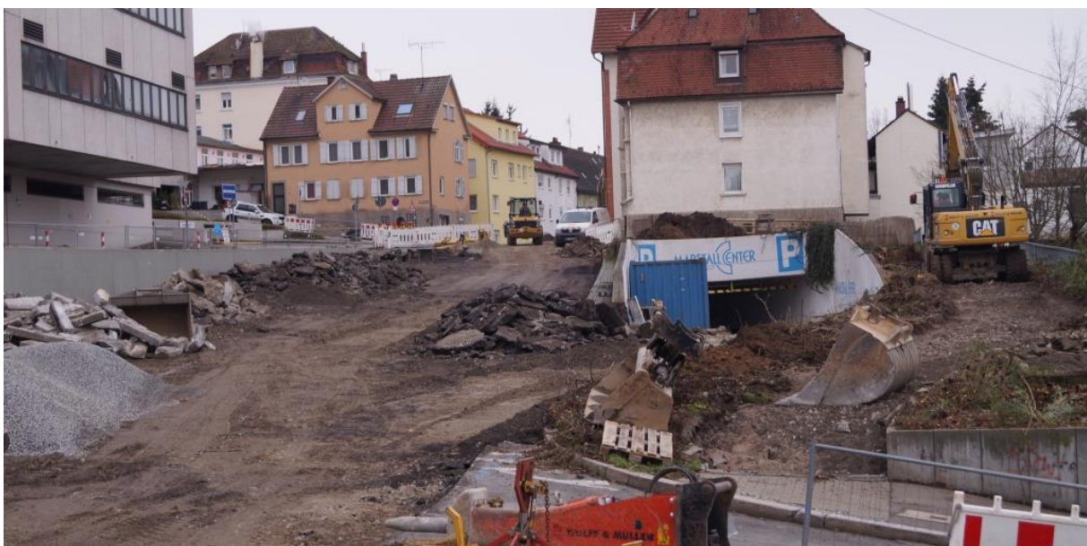
Rückbau der Tiefgaragenzufahrt
