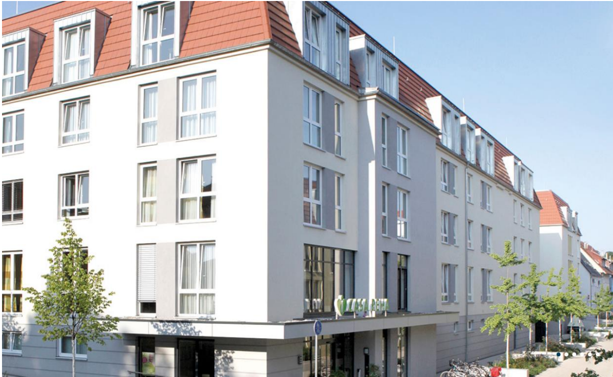
Das Pflegeheim „Walckerhof“ auf dem ehemaligen Areal der Orgelfabrik „Walcker“
