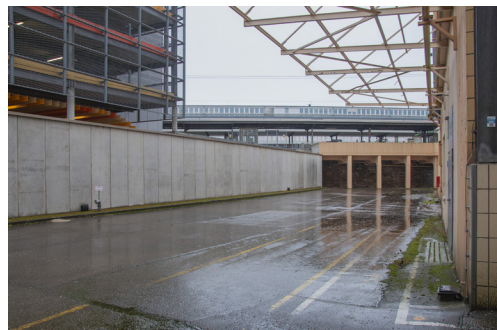
Freiraum und Grundstücksgrenze zur Bahnhofspassage
