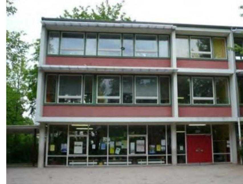
Die Eichendorffschule (Baujahr 1960) ist hinsichtlich ihrer Bauform und Baukonstruktion typisch für ein Schulgebäude der 50er und frühen 60er Jahre. Das Gebäude wurde ohne Wärmeschutz realisiert und hat aufgrund der konstruktiv bedingten Wärmebrücken einen dementsprechend hohen Energieverbrauch.
