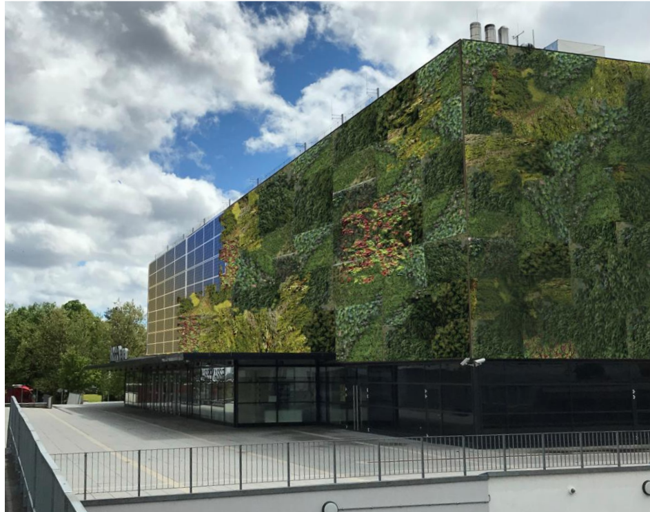
Photovoltaik – Grün - Fassade
