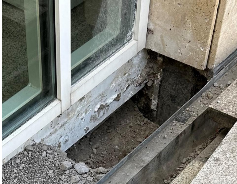
Tausalzschäden Gebäudesockel
