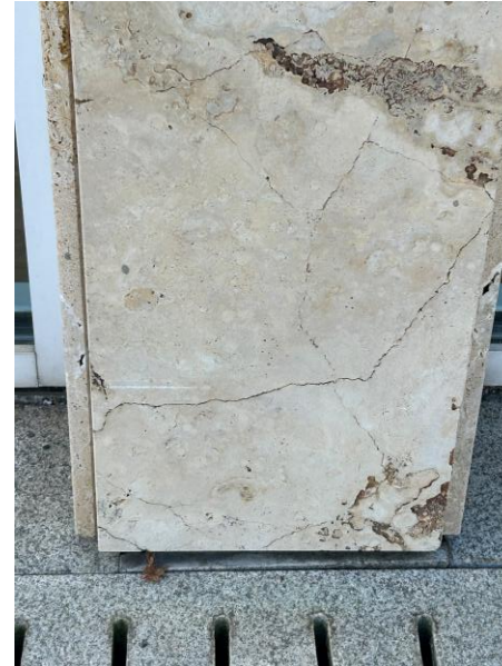
Tausalzschäden und Risse in Travertinfassade
