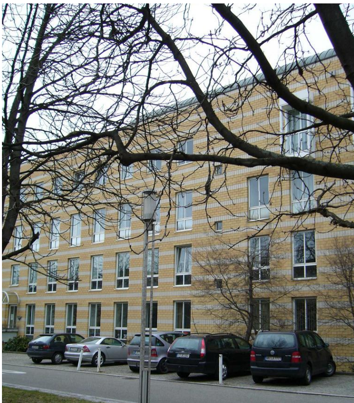
Erneuerung der Einzelfenster
