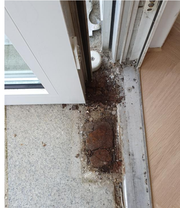
Durchkorrodierte Bodentürschließer
