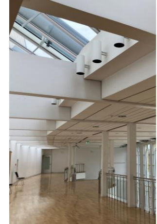
Strahlenförmig Unterzüge in Foyers
