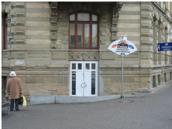
Foto 17: Standort Bahnhofstraße 29, dezenter Eingangsbereich
