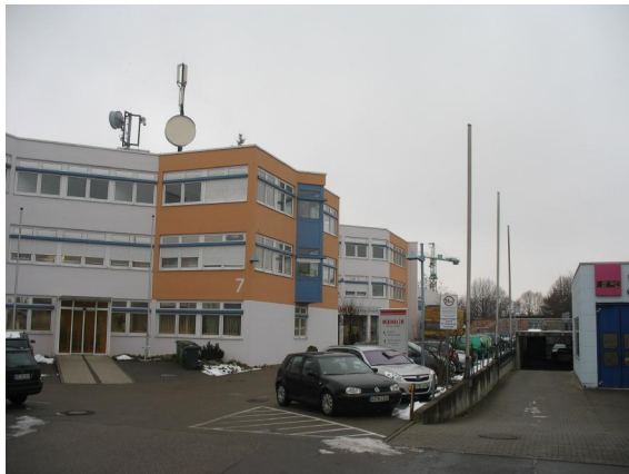
Foto 35: GE Karlsruher Allee
