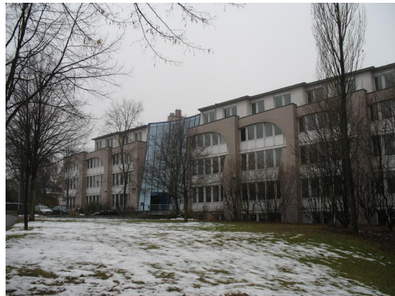
Foto 36: GE Karlsruher Allee, Büronutzungen
