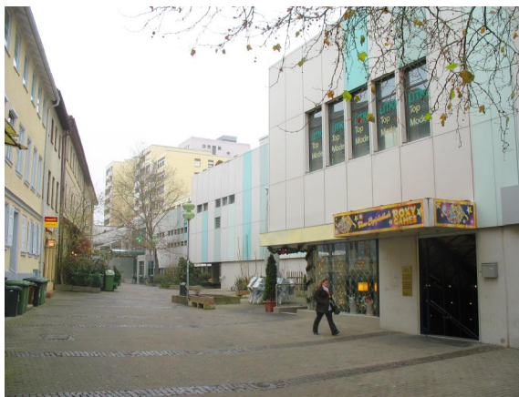
Foto 5: Eingangsbereich Spielhalle, rückwärtiger Raum
